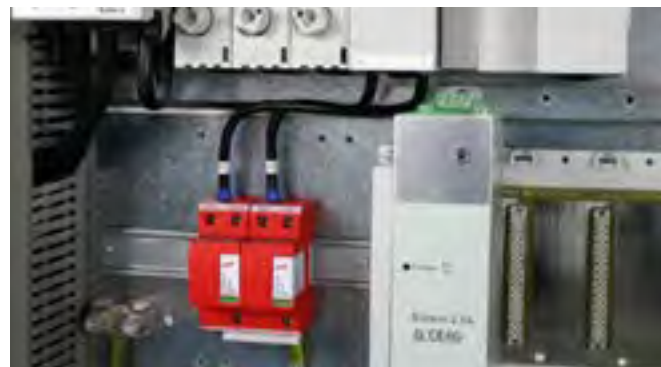
Zum Schutz von Gleichstrom-Verbraucheranlagen vor Überspannungen auch bei direkten Blitzeinschlägen. Zum Einsatz im Blitz-Schutzkonzept an den Schnittstellen 0A – 1.
