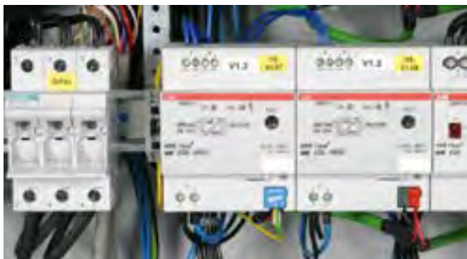
Überspannungs-Ableiter für den KNX/EIB-Bus mit Anschlussdrähten.
