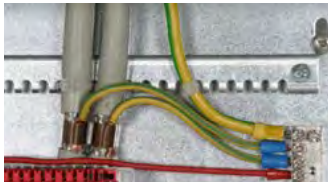
Besonders platzsparendes Schirmschlusssystem als Kontakt-Rollfeder. Kompensation des Fließverhaltens der eingesetzten Kabelwerkstoffe durch Federwirkung.
