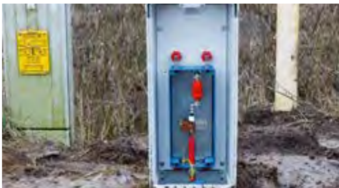
Koaxialer Anschluss der Ex-Trennfunknstrecke zum Schutz von unterirdischen Isolierstücken
