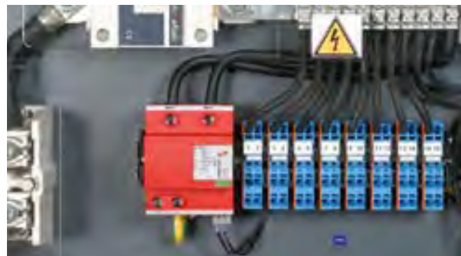
Zum Schutz von Photovoltaik-Wechselrichtern vor Überspannung auch bei direkten Blitzschlägen. Zum Einsatz gemäß IEC 60364-7-712: „Errichten von Photovoltaik-Versorgungssystemen“
