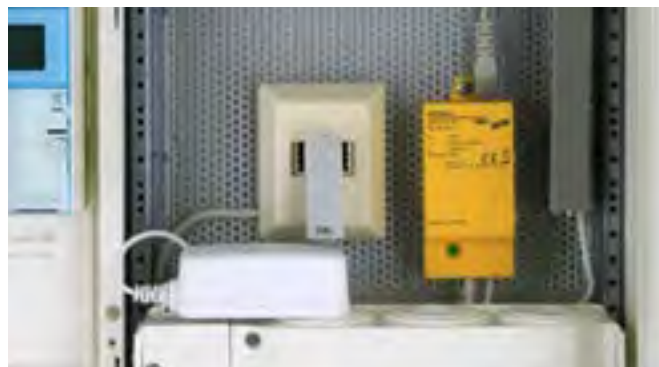
DEHNbox im Anschlussbereich eines Telekommunikationsanschlusses (Beispiel: U K0 Schnittstelle)
