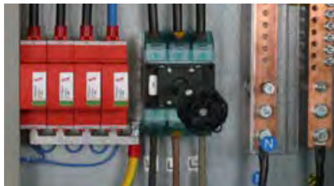
Einpoliger Überspannungs-Ableiter zum Schutz von Niederspannungs-Verbraucheranlagen vor Überspannungen. Zum Einsatz im Blitz-Schutzzonen-Konzept an den Schnittstellen 0 B – 1 und höher.
