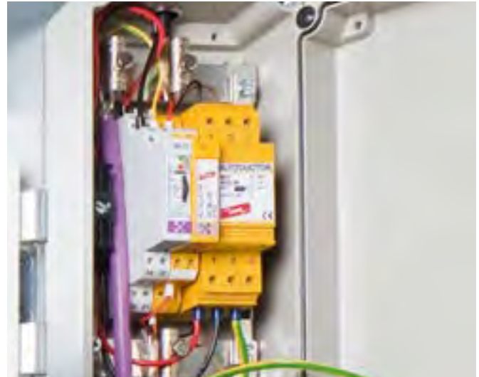
Kompakter Geräteschutz mit Schraubklemmanschlüssen für mehradrige Leitungen zur Hutschiene montage.
