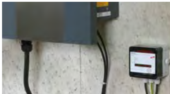
Zum Schutz von Niederspannungs-Verbraucheranlagen vor Überspannungen. Zum Einsatz gemäß IEC 60364-7-712: "Errichten von Photovoltaik-Versorgungssystemen".
