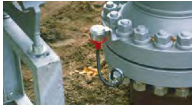
ATEX- und IECEx-zertifizierte Trennfunkstrecke für den Blitzschutz-Potentialausgleich nach DIN EN 62305 / VDE 0185 in bewährter Ausführung mit flexiblem Leiteranschluss.
