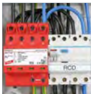
V-Verdrahtung mit blitzstromgeprüfter Stiftanschlussklemme STAK 25.
