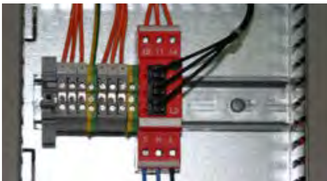
Lichtwellenleiter-Empfangsmodul für DEHNbloc Maxi S- und DEHNgap Maxi S-Schutzgeräte mit potentialfreiem Wechslerkontakt.
