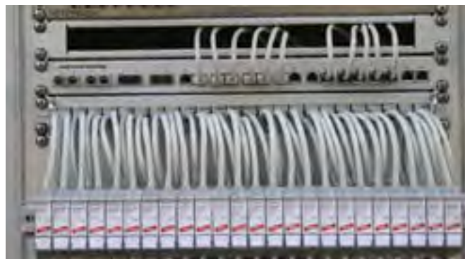
DEHNpatch ist das erste Patchkabel mit Überspannungsschutz in Cat. 6A-Performance, welches nach IEEE 802.3at bis 57 V einsetzbar ist.
