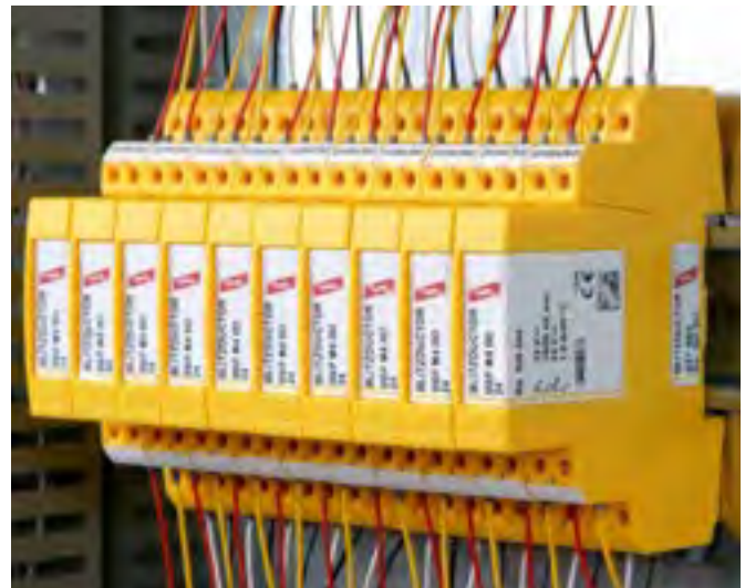
Teilbarer, mehrpoliger, universeller Überspannungs-Ableiter für informationstechnische Systeme.
