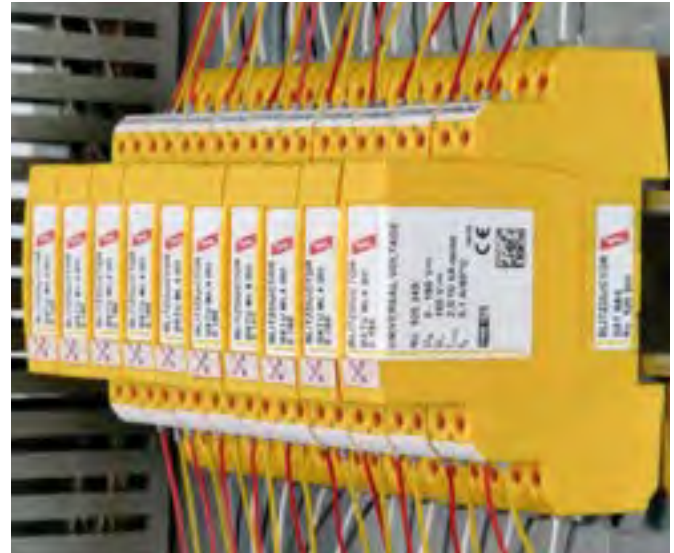
BLITZDUCTOR XTU in der Installation zum Schutz unterschiedlicher symmetrischer Signal- und Datenschnittstellen. Zweiteiliger Aufbau mit Basisteil und Ableiter-Modul in platzsparender Bauweise für Hutschiennenmontage.
