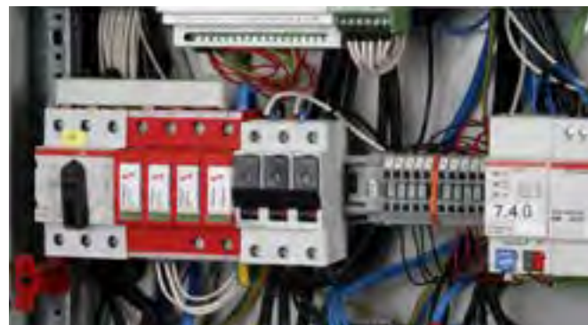
Zum Schutz von Niederspannungs-Verbraucheranlagen vor Überspannungen. Zum Einsatz im Blitz-Schutzkonzept an Schnittstellen 0_B - 1 und höher.
