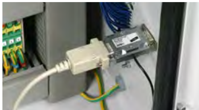
Überspannungs-Ableiter, D-SUB-Steckanschluss in Stecker-Buchse-Ausführung.
