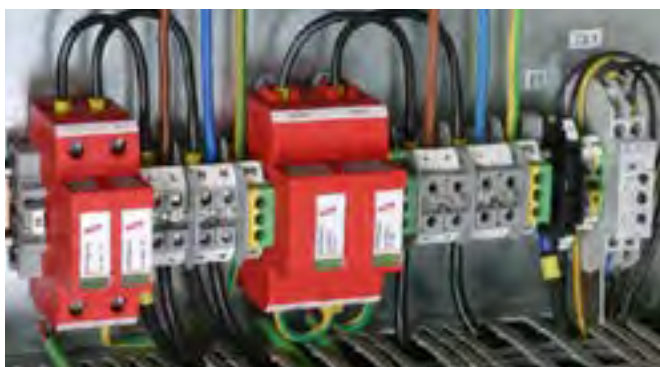
Zum Schutz von Niederspannungs-Verbraucheranlagen vor Überspannungen. Zum Einsatz im Blitz-Schutzzonen-Konzept an Schnittstellen 0_B - 1 und höher.
