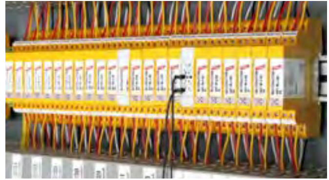
BLITZDUCTOR XT mit einem Erdungsmodul (grau) in der Installation verbaut. Mit dem Messmodul (grau mit Streifen) können ohne das Auftrennen der Klemmen die Leitungen durchgemessen werden.
