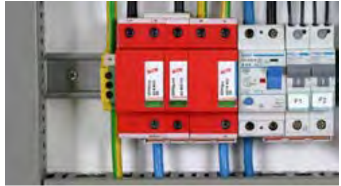
Zum Schutz von Niederspannungs-Verbraucheranlagen vor Überspannungen auch bei direkten Blitzeinschlägen. Zum Einsatz im Blitz-Schutzzonen-Konzept an Schnittstellen 0_A - 1 in der 3+1-Schaltungsvariante.
