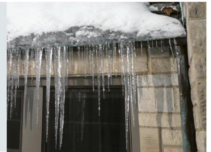
Durch Sonneneinstrahlung und Gebäudeabwärme kann auch bei Frost Schmelzwasser entstehen. Durch Wiedergefrieren wird das Abfließen des Wassers verhindert und es kommt zu einem Wasserrückstau, welcher die Funktionsfähigkeit der Dachentwässerung beeinträchtigt. Zudem wird eine Eiszapfenbildung begünstigt, die wiederum eine erhöhte Gefährdung mit sich bringt.
