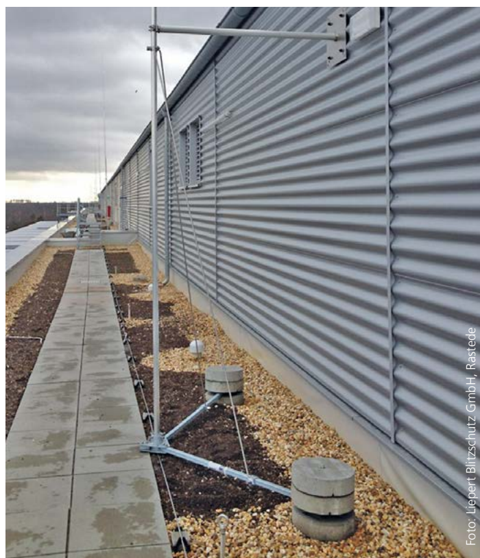
Ein Dreibeinstativ wird zum Zweibeinstativ mit Wandhalterung.
