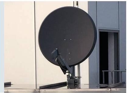
Antennenanlagen werden heute fast ausschließlich auf Dächern von baulichen Anlagen und nicht im Schutzbereich von Dachflächen errichtet (**Bilder 1 und 2**). Für Aufdachanlagen wird dann sowohl der Potentialausgleich im Bereich der Koaxialleitung, als auch die Erdung des Antennenstandrohres gefordert. Prinzipiell gilt, dass Antennen, welche nach DIN EN
