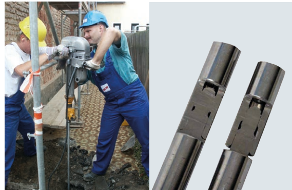
Bild 3b Eintreiben des Tiefenerders / Schlüsselförmige Verbindung eines Tiefenerders
