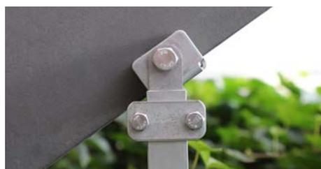
Verbindung Stahlträger mit Anschlussfahne / Erdungsanlage
