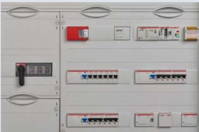
Im modernen Schaltschrank wird es enger. Energy Meter oder Brandschutzschalter, immer mehr Komponenten müssen Platz finden. Mit seiner kompakten Bauform schafft DEHNventil hier eine Platzreserve.
