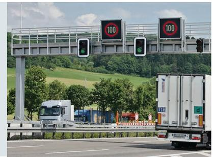
Verkehrsleitsysteme für Autobahnen und Schnellstraßen werden an fahrbahnüberspannenden Verkehrszeichenbrücken angebracht und sorgen weltweit für eine optimale Verkehrssteuerung. Sie greifen ein, um Überlastungen zu vermeiden und um Gefahren entgegenzuwirken, welche durch Unfälle, starke Niederschläge und zu hohe Geschwindigkeiten entstehen. An Verkehrszeichenbrücken werden verkehrsspezifische Erfassungssysteme wie Überwachungskameras, Sensoren und
