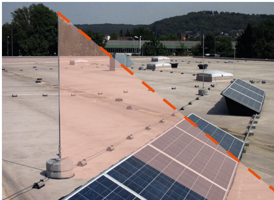
Bild 12 Ermittlung des Schutzraumes mittels Schutzwinkelverfahren
