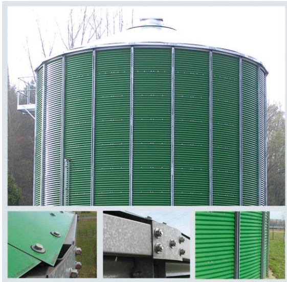
Bild 6 Gärbehälter aus geschraubten Metalltafeln
