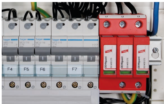
Bild 6 Modularer Überspannungs-Ableiter Typ 2 zum Schutz der 230/400 V-Versorgung
