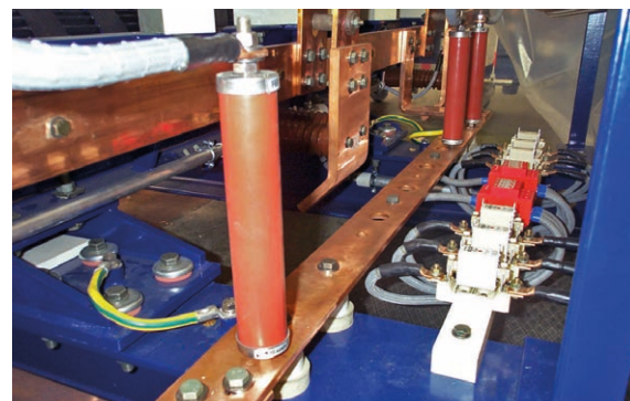
Bild 9 DEHNmid Mittelspannungsableiter installiert in einem Trafo einer WEA
