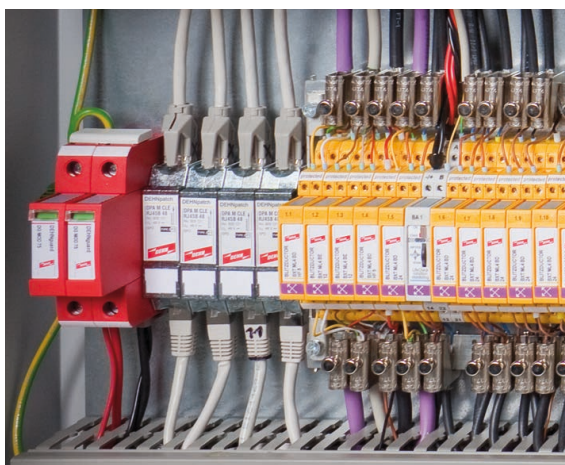
Bild 12 Beispiel für den Schutz in einem Pitchsystem
