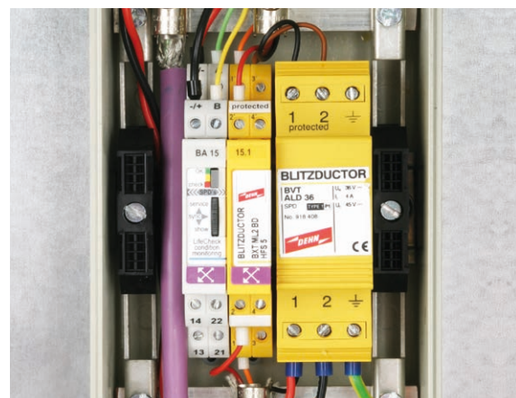
Bild 11 Schutz einer Windmessen (Anemometer)
