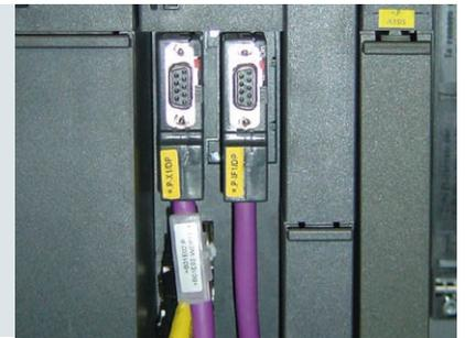
Sowohl die Anwendung des PROFIBUS als Kommunikationssystem im prozessnahen Bereich als auch dessen Verwendung als zellen- und objektübergreifendes Leittechnik-Medium bestimmt den hohen Verfügbarkeitsanspruch. Diesem Verfügbarkeitsanspruch steht ein hohes Maß an Überspannungsgefährdung entgegen, da seine räumliche Ausdehnung eine hohe induktive/kapazitive Einkopplung ermöglicht.
