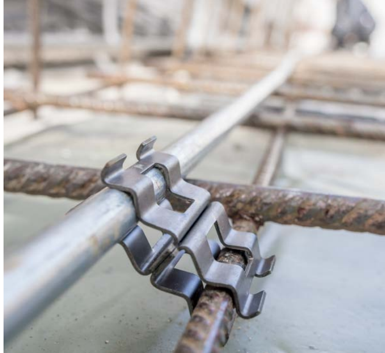
Verbindung Fundamenterder – Bewehrung
