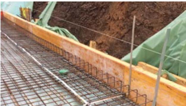
> Bild 13a: Darstellung von Anschlusspunkten – Beispiel Anschlussfahne an kombinierte Potentialausgleichsanlage
