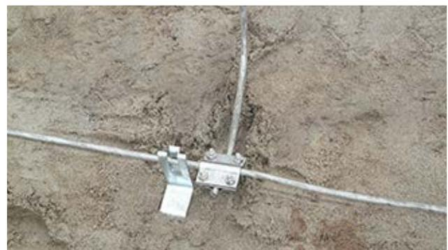
> Bild 14b: Darstellung von Verbindungen im Erdreich Anschlusspunkten – Beispiel Anschluss an Ringerder
