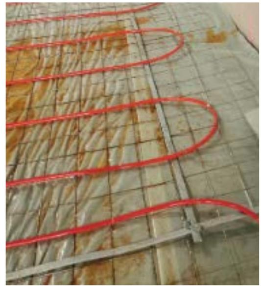
> Bild 5: Nutzung von Bewehrungsmatten zur Lagefixierung der Fußbodenheizung als kombinierte Potentialausgleichsanlage bei nicht leitfähig bewehrter Bodenplatte
