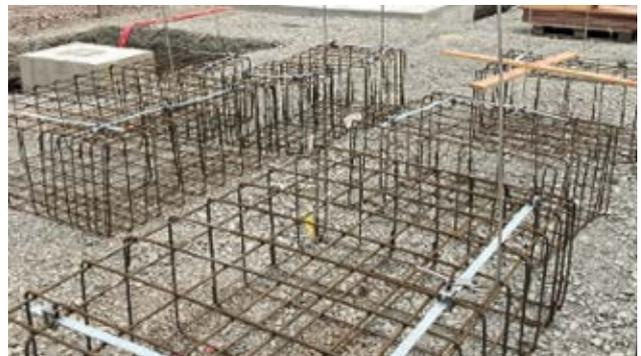
> Bild 13b: Darstellung von Anschlusspunkten – Beispiel Anschlussfahne an Einzelfundament
