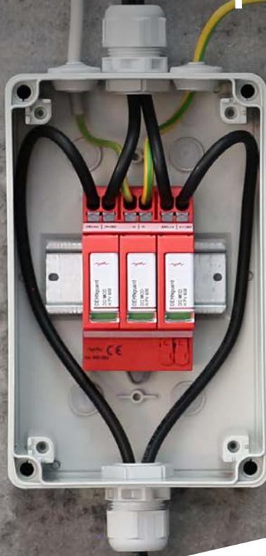
Schutz für die Photovoltaik-Anlage im Wohngebäude: Das bietet DEHNguard MP YPV. Der DC-Überspannungs-Ableiter Typ 2 erweitert mit seiner praktischen Push-in-Doppelklemme die Produktfamilie. Und bietet Ihnen mittels Schnellanschlusstechnik zahlreiche Vorteile.
