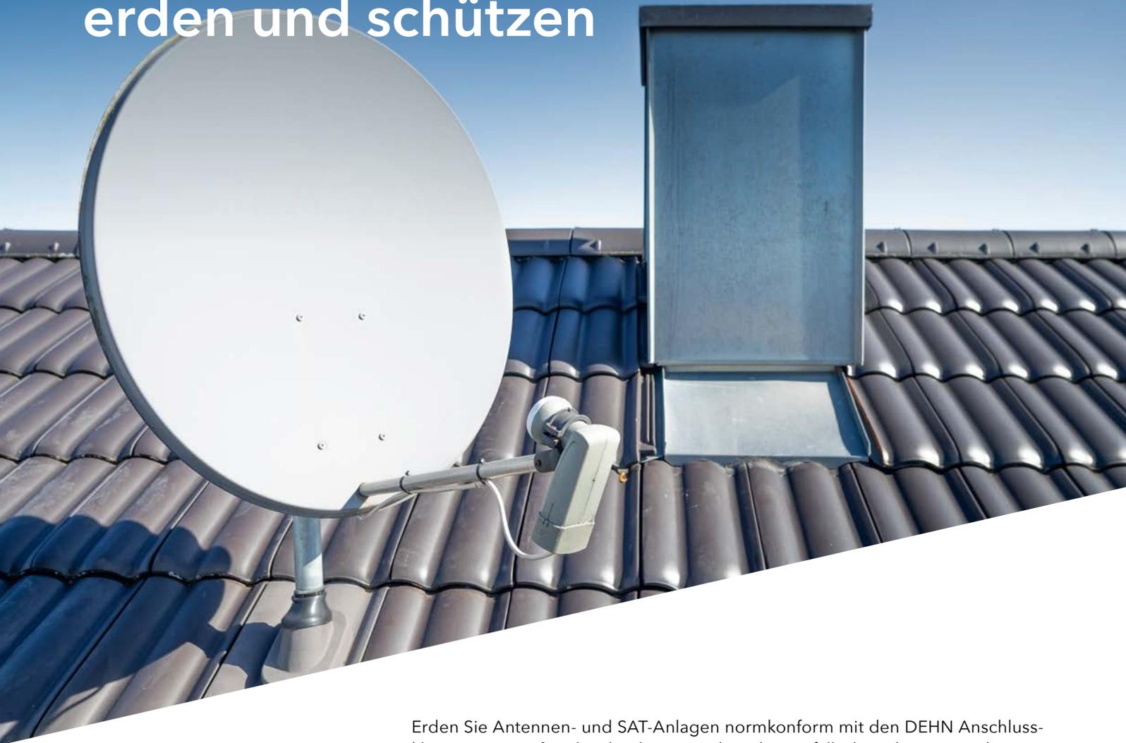
Erden Sie Antennen- und SAT-Anlagen normkonform mit den DEHN Anschlussklemmen 16 mm<sup>2</sup> und verhindern so technische Ausfälle, bewahren Menschen vor Verletzungen und schützen Gebäudeausstattung vor Schäden.
