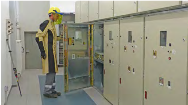
Schaltraum mit ausgelegter Isoliermatte.
