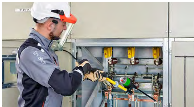
Einpoliger Phasenvergleich PHV I an einer Schaltanlage.
