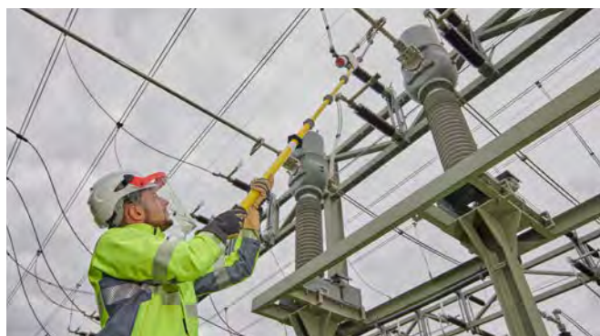
Spannungsprüfer PHE4 an einer Freiluftstation 110 kV.
