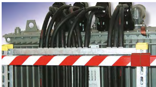
Absperrbalken montiert in Trafostation.
