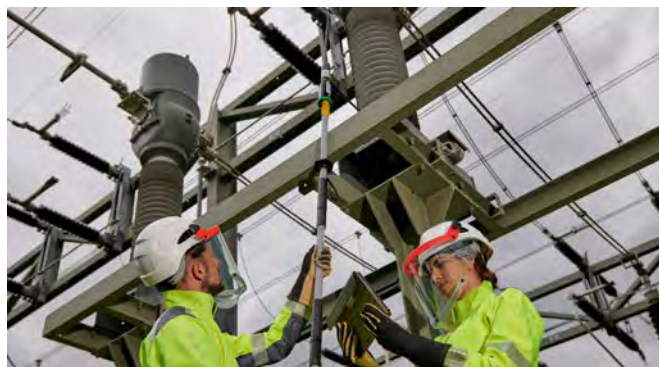
Abstands-Spannungsprüfer ASP in einer Freiluftschaltanlage.
