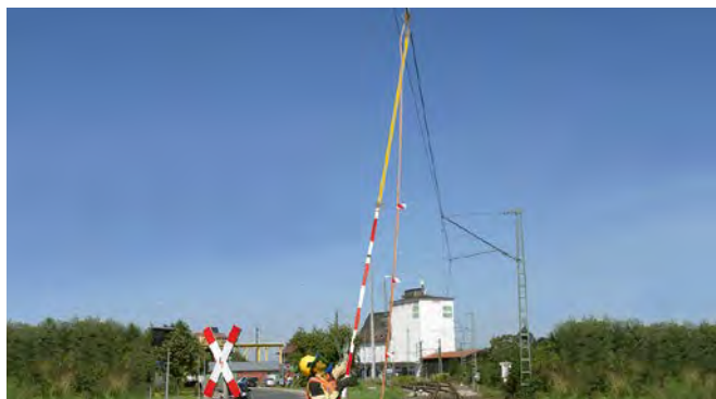
Einhängen einer Bahnerdungsvorrichtung.
