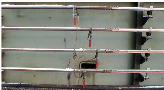
Dreipolige Erdungs- und Kurzschlievorrichtung mit Zwingenklemmen.
