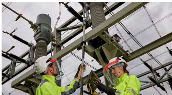
Abstands-Spannungsprüfer ASP in einer Freiluftschaltanlage.
