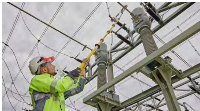
Spannungsprüfer PHE4 an einer Freiluftstation 110 kV.
