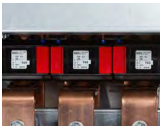
Eingebaute Schutzstromwandler
