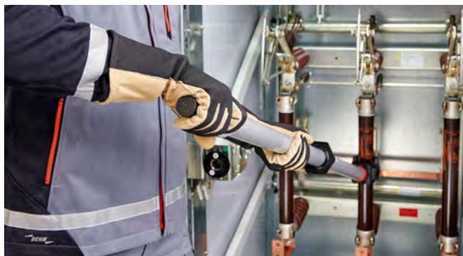
Betätigung eines NH-Aufsteckgriffes mit dem Schutzhandschuh.
