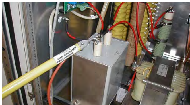
Einpolige Entladevorrichtung zum Ableiten statischer Ladungen.
