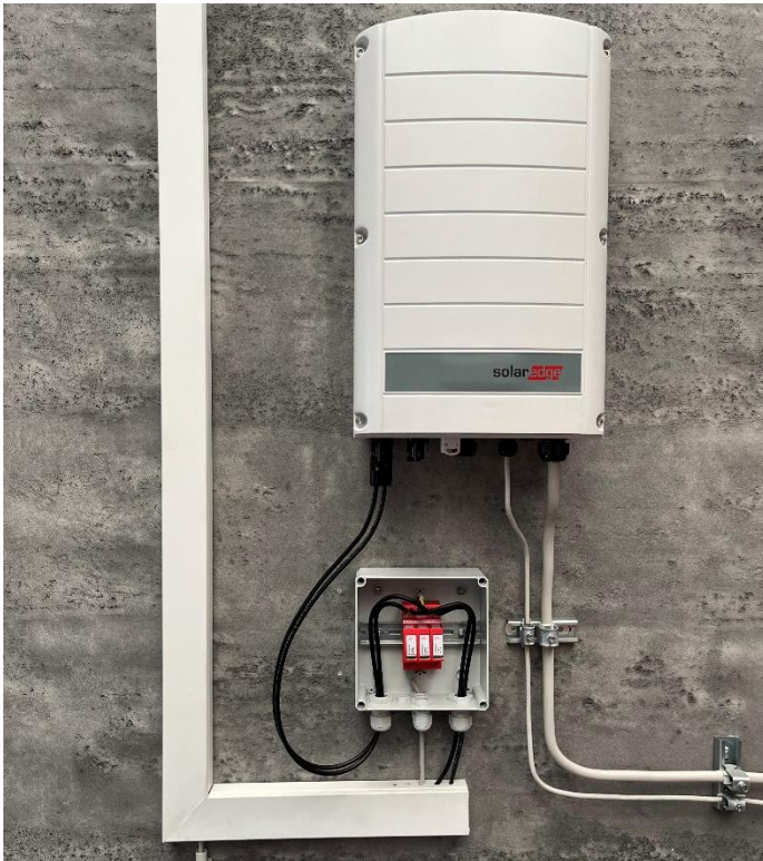
DEHNguard MP YPV: DC-Überspannungs-Ableiter Typ 2 mit praktischen Push-in-Doppelklemmen Bild: DEHN
