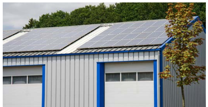
Stahlhalle mit durchgängiger Metallverkleidung und PV-Anlage
