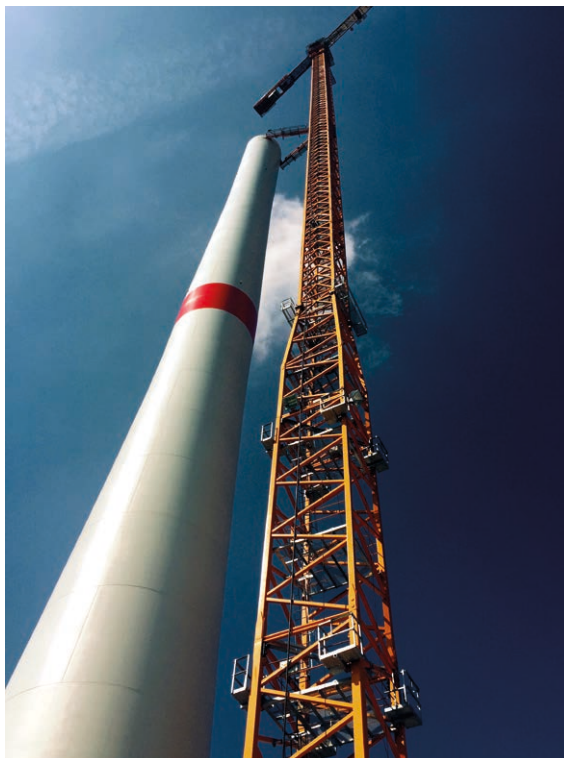
Bild 1 Hybridturm aus Fertigbeton-Elementen
