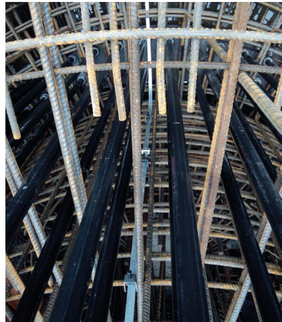
Bild 6 Verbindung des Erders mit der Bewehrung
