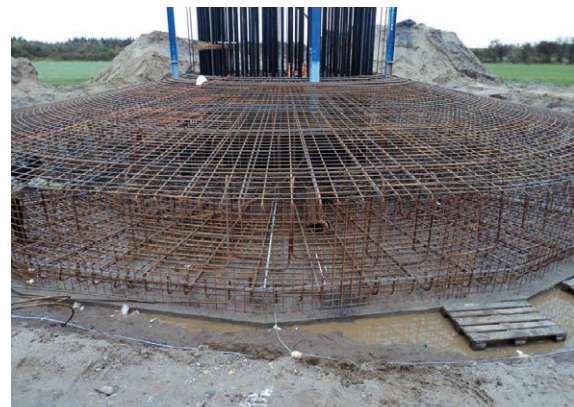
Bild 3 WEA-Bewehrung mit Fundamenterder
