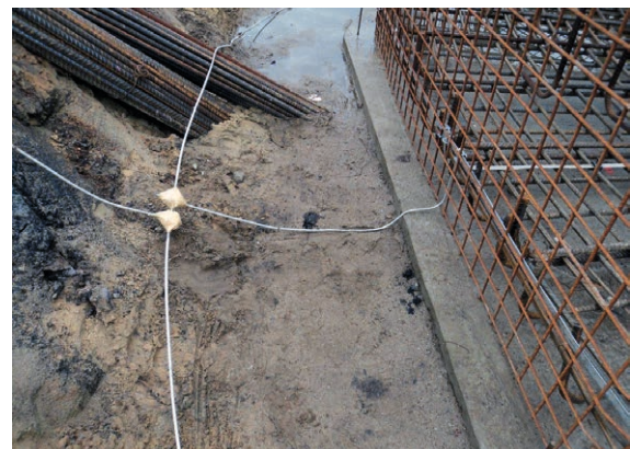
Bild 7 Ringerder mit Verbindung zum Fundamenteerder
