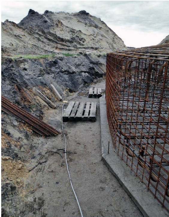
Bild 8 WEA-Bewehrung mit erdfühlig verlegtem Ringerder
