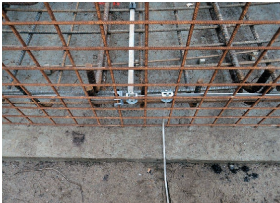
Bild 4 WEA-Bewehrung mit Verbindern
