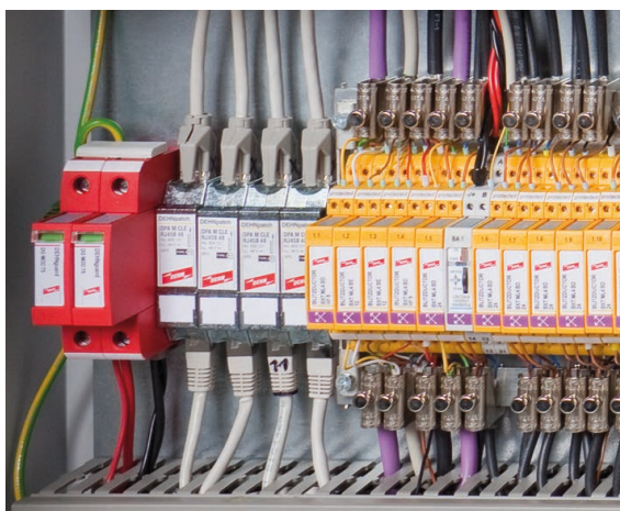
Bild 12 Beispiel für den Schutz in einem Pitchsystem
