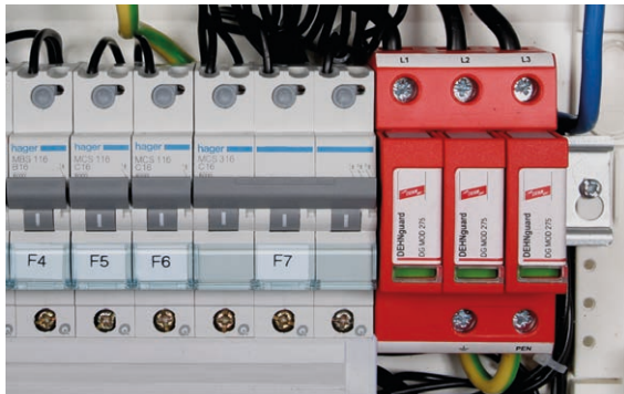
Bild 6 Modularer Überspannungs-Ableiter Typ 2 zum Schutz der 230/400 V-Versorgung
