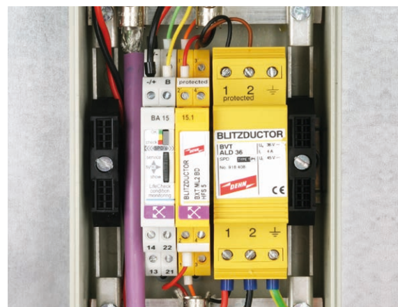
Bild 11 Schutz einer Windmessen (Anemometer)
