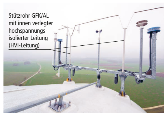
Bild 2 Beispiel einer Fangeinrichtung für die Wetterstation und die Flugbefuerung
