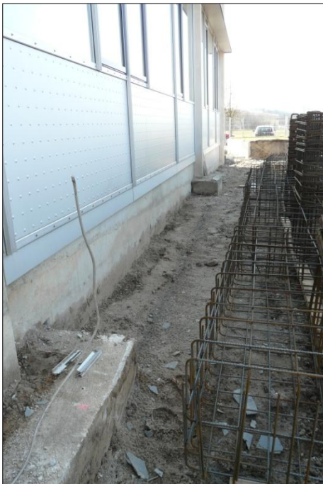
Bild 7: Anbindungsmöglichkeiten von Anbauten an Bestandsgebäude
