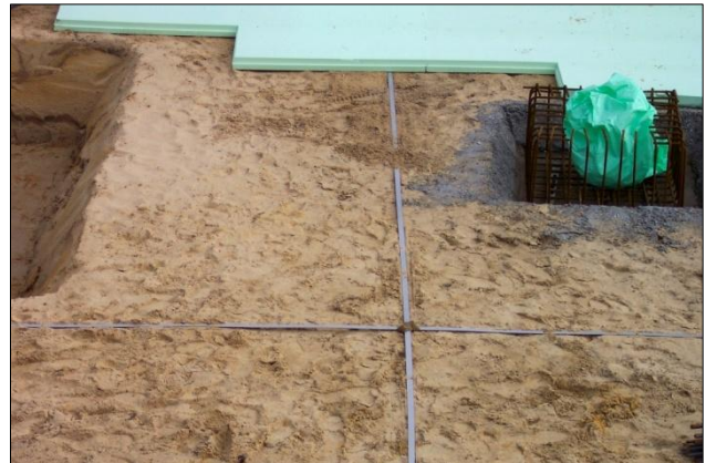
Bild 2: Korrosionsgeschützter Bänderder unterhalb einer Perimeterdämmung
