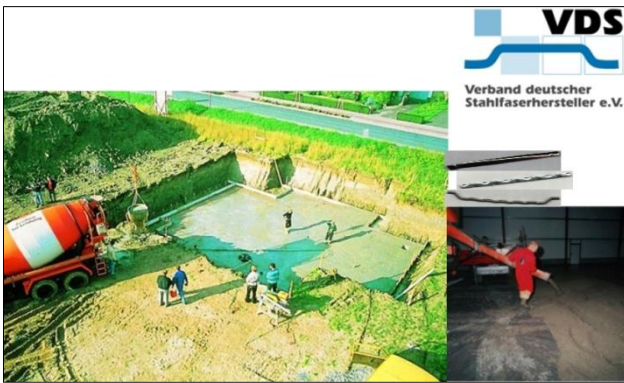
Bild 4: Einbringen eines Stahlfaserbetons
