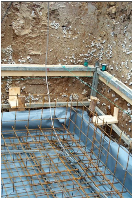
Bild 1: Eingelegter Bandstahl mit Anbindung eines Potentialausgleichsrunddrahtes
