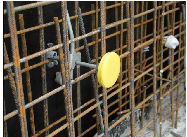
Bild 5: Anbindung eines Erdungsfestpunktes an einem Potentialausgleichsleiter
