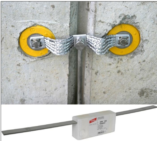
Bild 6: Überbrückungsmöglichkeiten bei Dehnungsfugen
