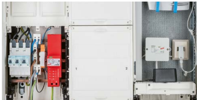
DEHNshield ZP Basic schützt die Elektroinstallation zentral am Gebäudeeintritt.
