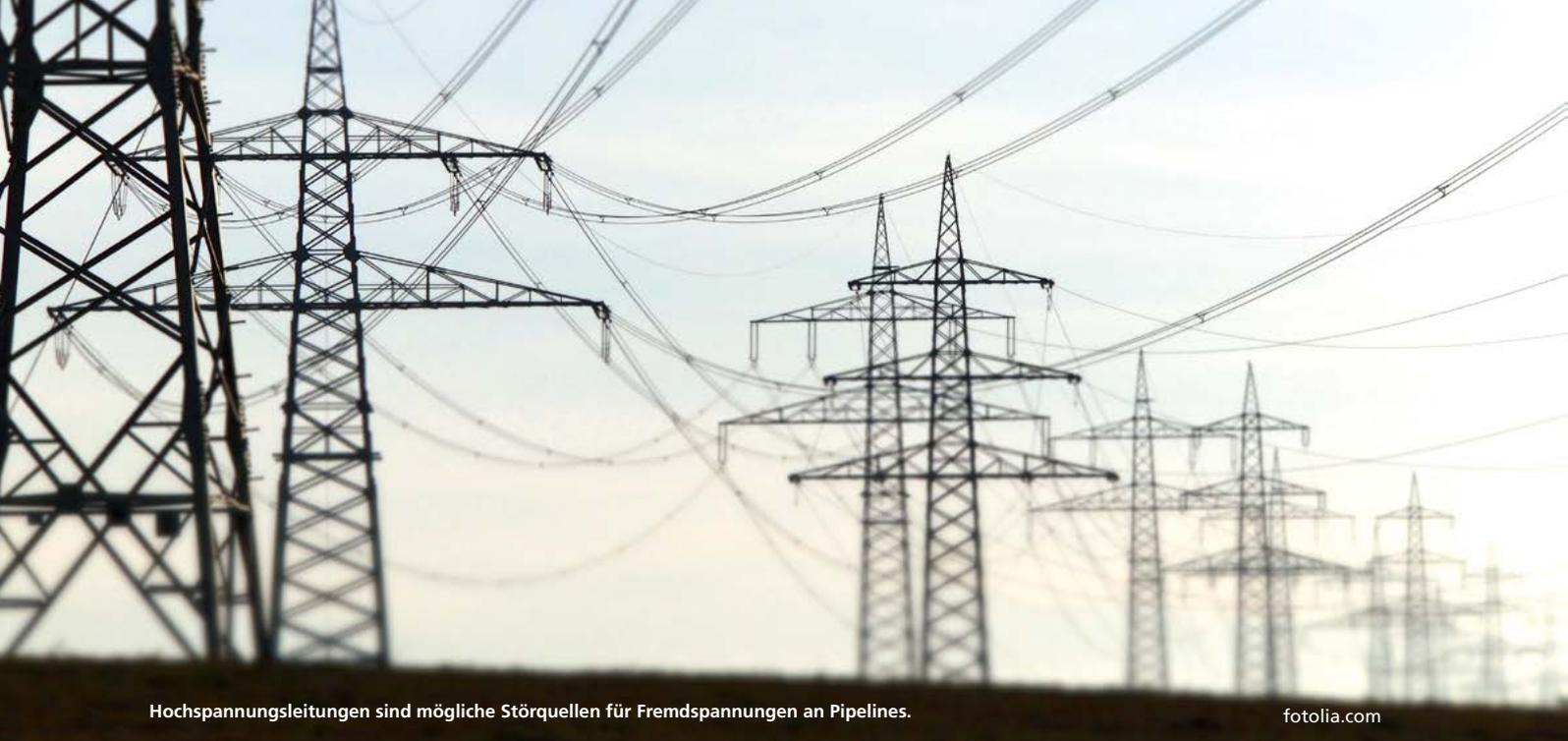
Hochspannungsleitungen sind mögliche Störquellen für Fremdspannungen an Pipelines.
