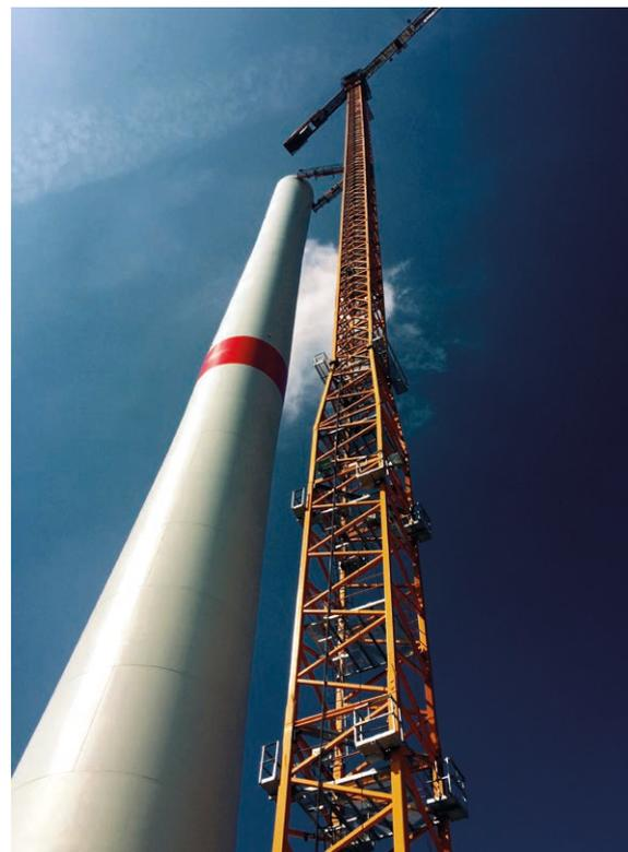
Bild 1 Hybridturm aus Fertigbeton-Elementen
