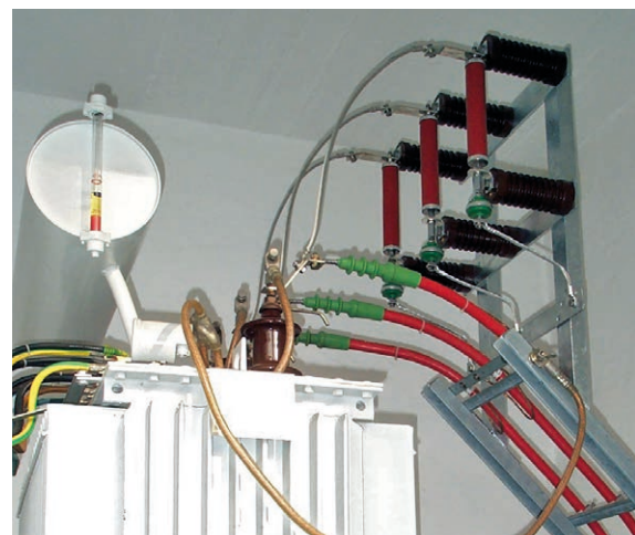
Bild 10 DEHNmid: Überspannungs-Ableiter für Mittelspannungssysteme
