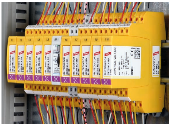
Bild 12 BLITZDUCTOR: Kombi-Ableiter mit actiVsense-Technologie und integrierter LifeCheck-Überwachung
