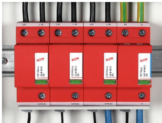
Bild 6 DEHNbloc modular: Koordinierter Blitzstrom-Ableiter auf Funkenstreckenbasis
