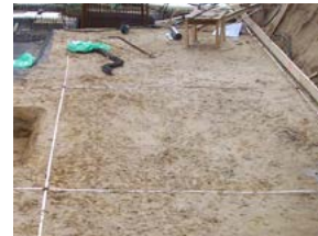
Vermaschter Ringerder unter der Bodenplatte eingebracht
