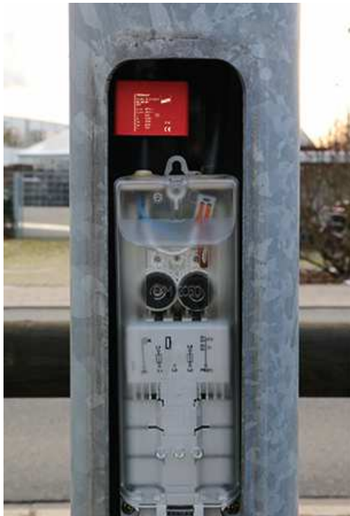
DEHNcord Typ DCOR L .. 275 SO IP
