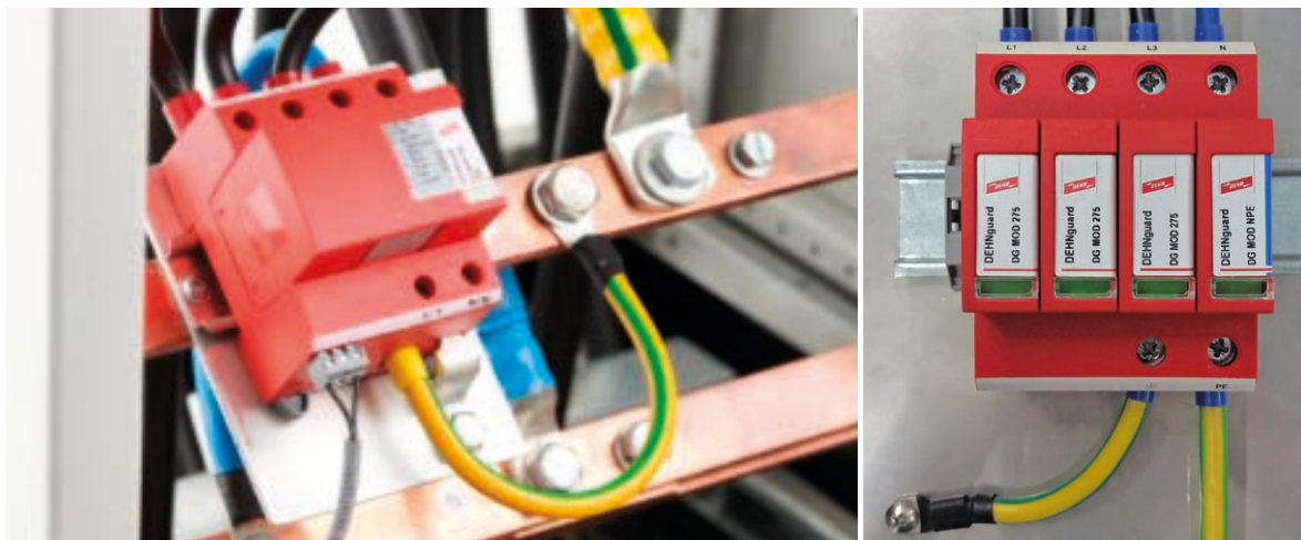
Bild 5 Zusätzlicher lokaler Potentialausgleich
