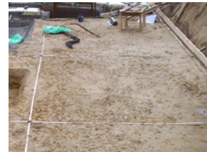
Vermaschter Ringerder unter der Bodenplatte eingebracht
