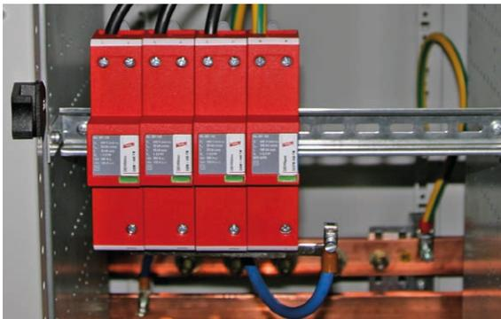
Bild 8 Koordinierter Überspannungs-Ableiter Typ 1
