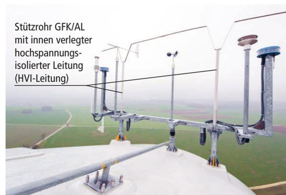
Bild 2 Beispiel einer Fangeinrichtung für die Wetterstation und die Flugbefuerung
