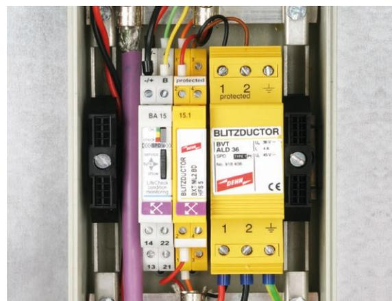
Bild 11 Schutz einer Windmessen (Anemometer)
