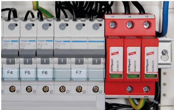
Bild 6 Modularer Überspannungs-Ableiter Typ 2 zum Schutz der 230/400 V-Versorgung
