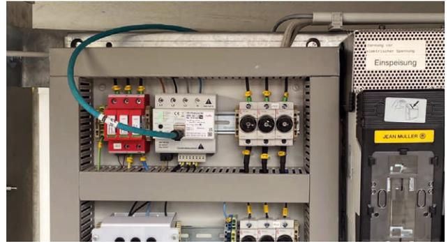
DEHNrecord SD mit Kommunikationsverbindung in einer digitalen Netzstation
