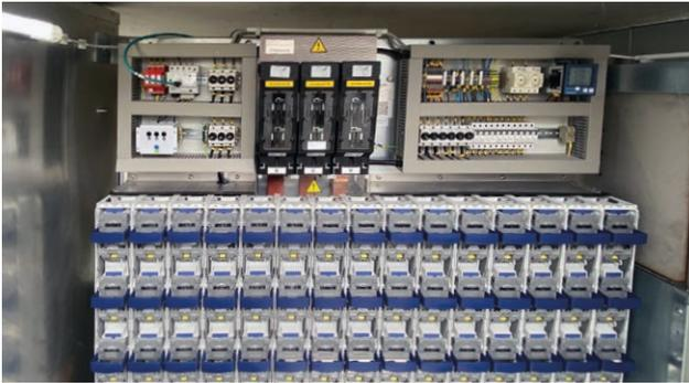
Überwachung der Niederspannungs-Einspeisung in einer digitalen Netzstation
