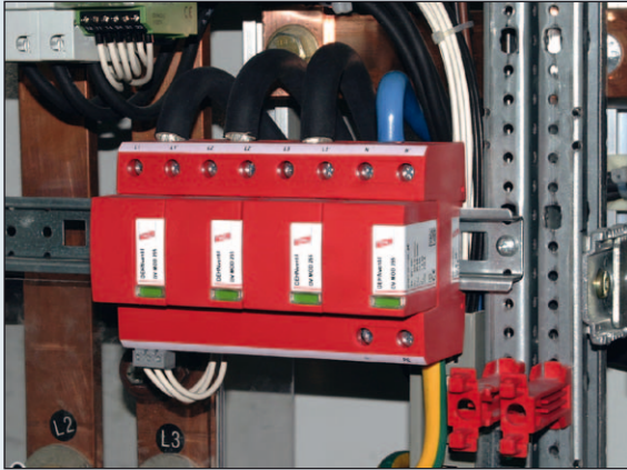
Bild 2 Blitzschutzpotentialausgleich mit DEHNventil M
