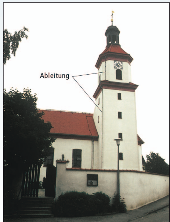
Bild 2 Verlegung der Ableitung am Kirchturm
