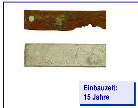
Bild 2: Korrosionsschaden Bänderle aus Stahl 30x3 mm, St/tZn
