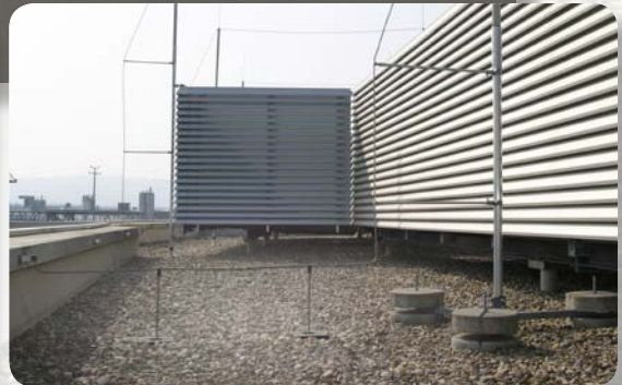
Dachaufbau geschützt durch DEHNiso-Combi in Kombination mit DEHNiso-DLH
