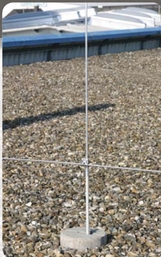
Fangstange mit Isolierstrecke aus den Werkstoffen GFK und Al
