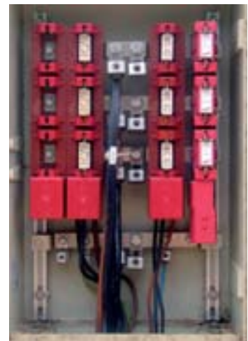
Bild 8.1.6.6 V NH Überspannungs-Ableiter Typ 2 zum Einsatz in NH-Sicherungsunterteilen
