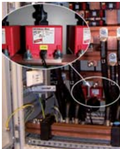
Bild 8.1.6.5 DEHNbloc Maxi S: koordinierter Blitzstrom-Ableiter für die Sammelschiene mit integrierter Vorsicherung
