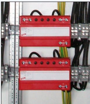
Bild 1.1 Kombi-Ableiter Typ 1, DEHNlimit PV, zum Schutz von Photovoltaik-Wechselrichtern vor Überspannungen auch bei direkten Blitzeinschlägen
