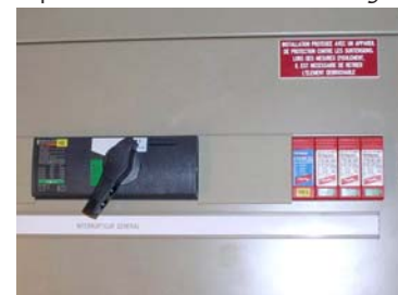
Dehn - DEHNventil TD Cathédrale Strasbourg
