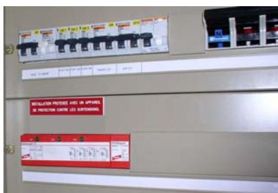
Dehn - DEHNventil TGBT Cathédrale Strasbourg
