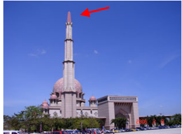
Fig. 5: Minarete de la mezquita de Putrajaya. La zona de protección afirmada está indicada por la línea punteada, mientras que el lugar del impacto del rayo está señalado por la flecha.
