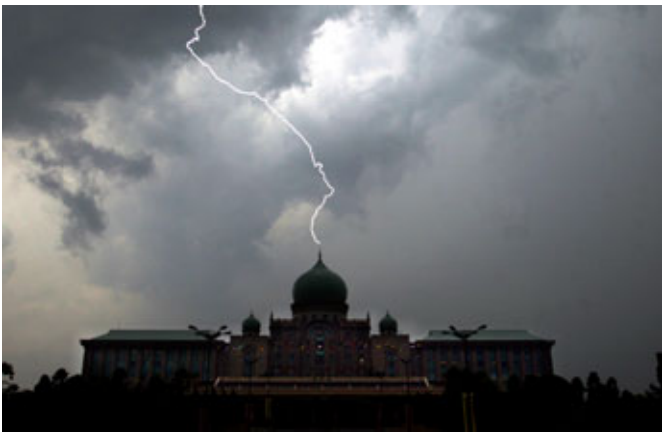
Fig. 8: Fotografía de la caída de un rayo en el terminal captador ESE, sobre el edificio del Departamento del Primer Ministro. (Imagen de The Star Publications plc)
