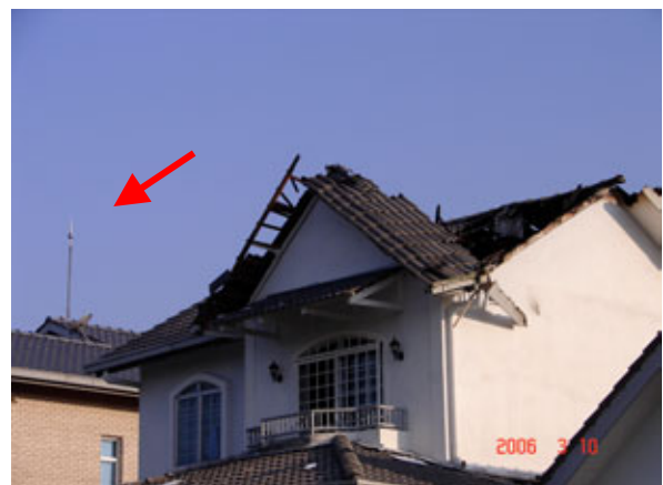
Fig. 2: Primer plano del terminal captador ESE (señalado con flecha) en el edificio adyacente.
