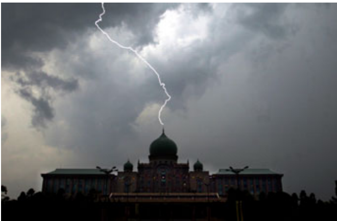
Fig. 8: Fotografía de la caída de un rayo en el terminal captador ESE, sobre el edificio del Departamento del Primer Ministro. (Imagen de The Star Publications plc)
