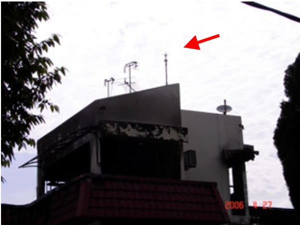
Fig. 4: Primer plano del terminal captador ESE sobre el techo (señalado con la flecha).
