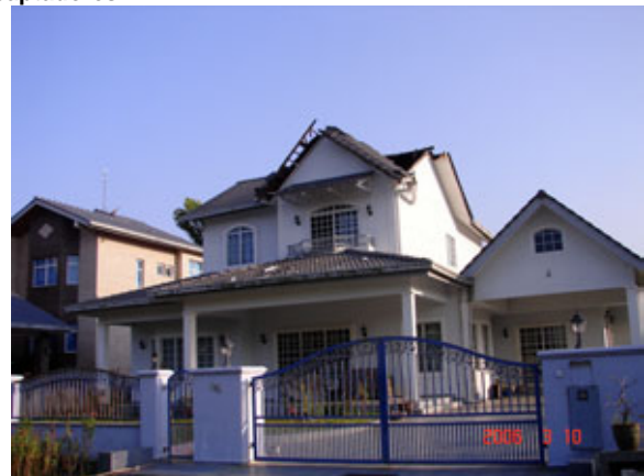
Fig. 1: Techo de una casa dañado por la caída de un rayo.
