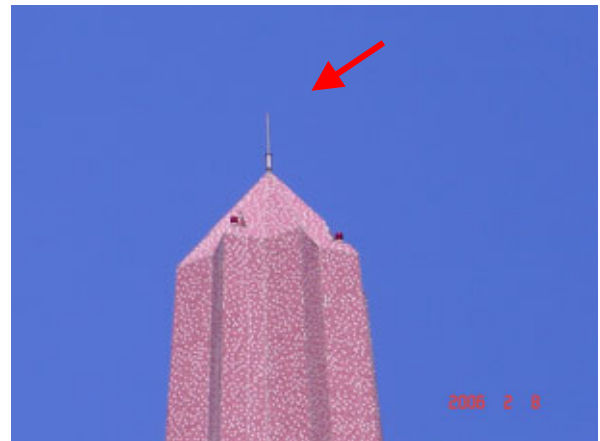
Fig. 6: Terminal captador ESE en el ápice del minarete (señalado por la flecha).
