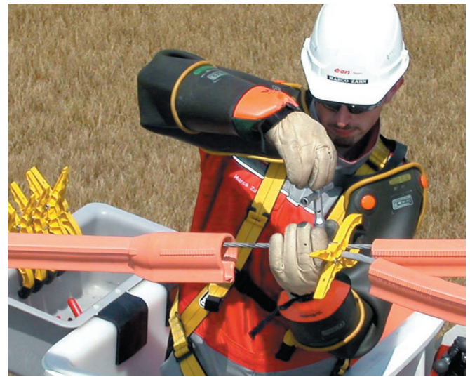
Bild 1. Isolierhandschuh-Methode im 20-kV-Netz Quelle: Eon Bayern AG
