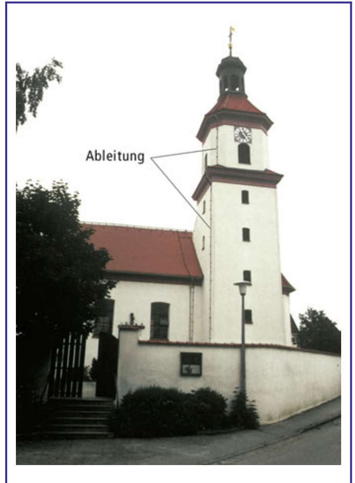
Bild 2: Verlegung der Ableitung am Kirchturm
