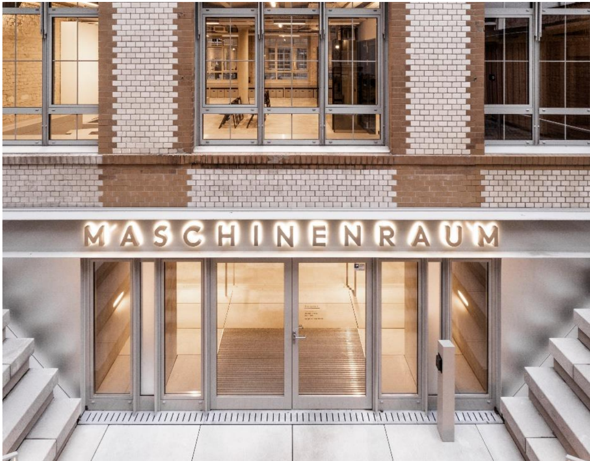
Eingang zum Gebäude des Maschinenraums in Berlin.
