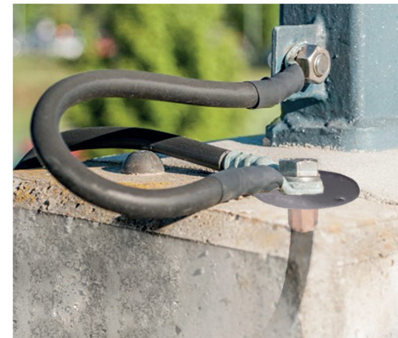
Bild 3: Erdungsverbinder
