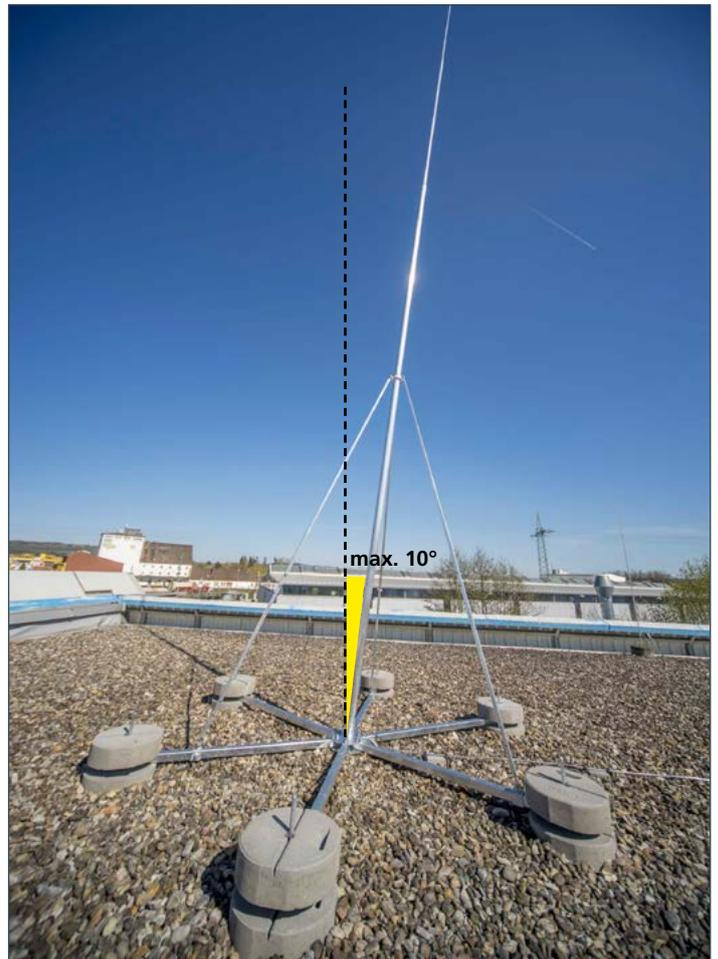
Neigung der Fangstange mittels Kugelgelenk um maximal 10° zur Anpassung an die Dach- oder Gebäudeneigung.
