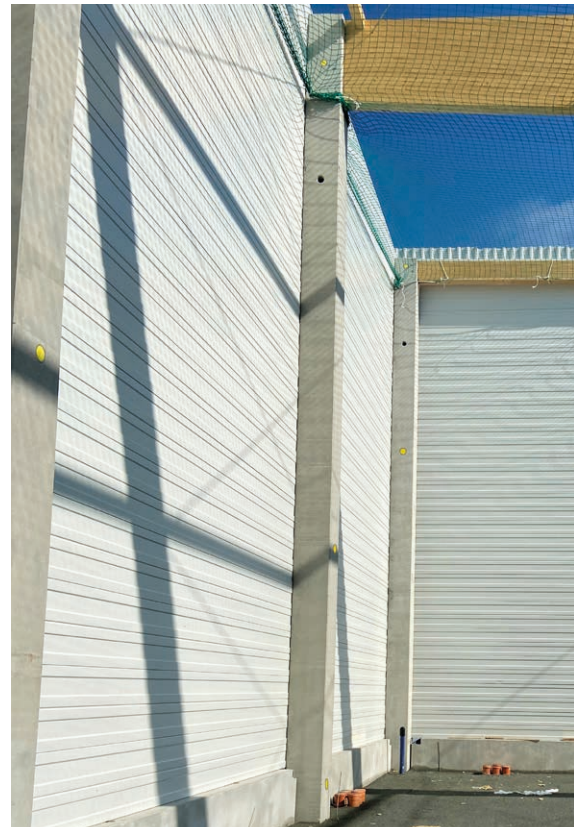
Bild 3 Stahlbetonstützen mit Anschlusspunkten
