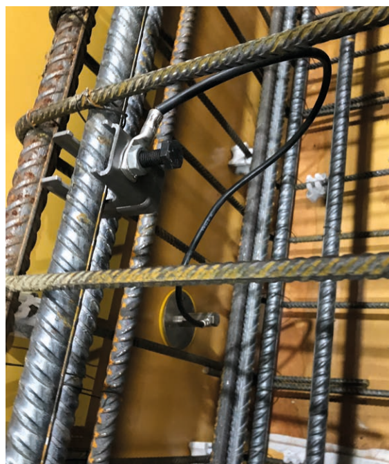
Bild 4 Montage in der Schalung
