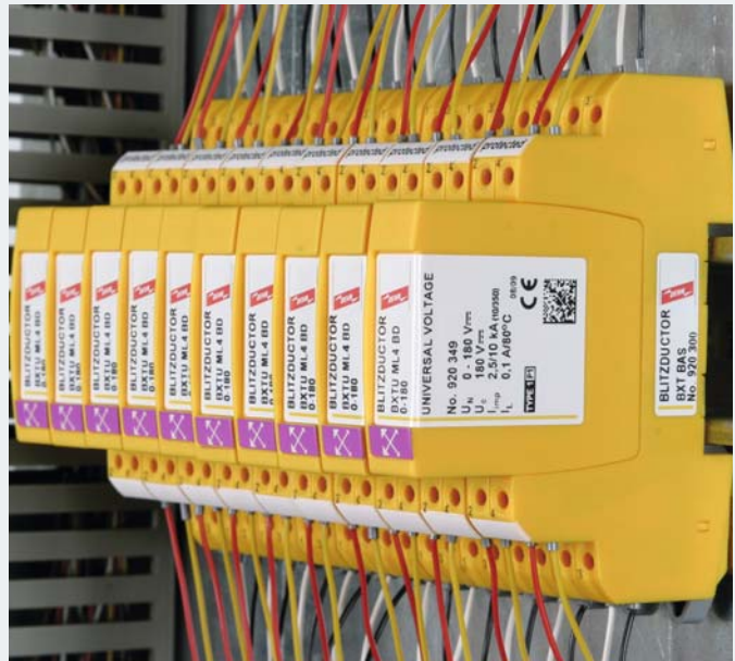
BLITZDUCTOR XTU in der Installation.
