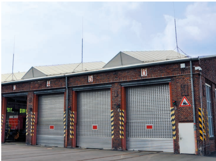
Bild 3 Isolierter Blitzschutz bei einem EVU
